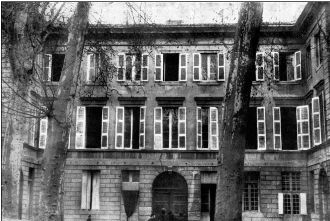
Fig. 3 - Vue d'ensemble des façades sur la cour.
