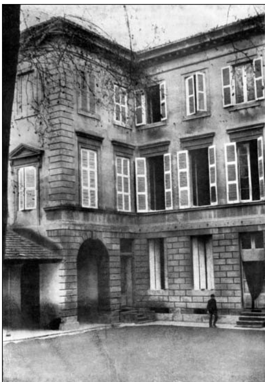
Fig. 4 - L'aile Nord vue de la cour
