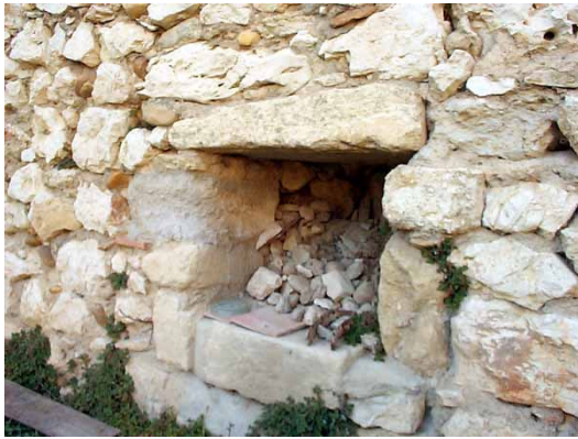
débouché du souterrain lavoir
