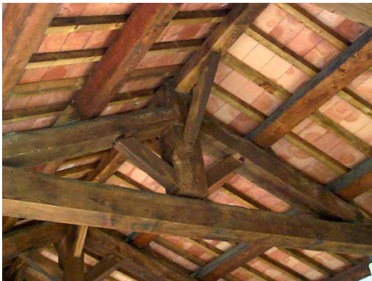
Charpente du lavoir
