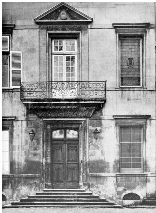
(fig. 2) Ancien Hôtel de l'Evêché, porte centrale de la façade principale.
