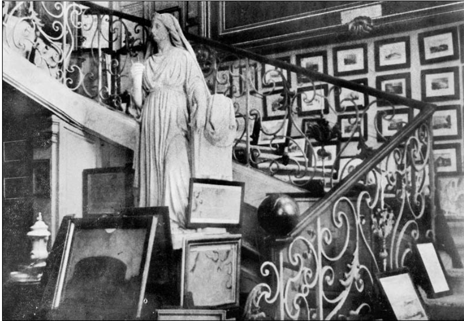
(fig. 5) Escalier d'honneur
